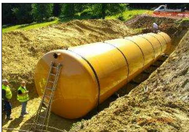
Photo d'une cuve enterrée de 120 m<sup>3</sup>
